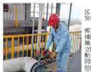
8月以来，持续高温笼罩厂区，2日，动力保障车间三班突发状况一桶稀风机停机。关键时刻，车间内操副操郭芳紧盯DCS画面，第一时间捕捉异常，迅速对讲机联动外操主操干明建奔赴现场。干明建立即响应奔赴现场，与内操协作配合，果断启动备用稀风机，同时通知运行保障部电工支援。经排查，故障源于过热保护跳闸致风机停机。电工快速响应，顶着高温紧急处理，恢复供电。从故障发现到协同处置，各岗位无缝衔接，成功避免因停机导致尾气排放超标，保障了车间平稳运行。
